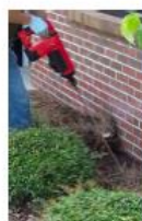
Angle beneath slab.
